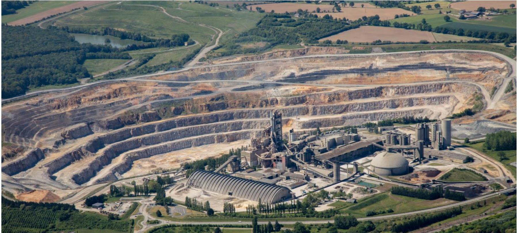
Une certaine catégorie de matériaux de découverte est valorisée sous la forme de granulats, une plateforme de 1,5 hectares est réservée au traitement des matériaux extraits des fronts Est de la carrière.
